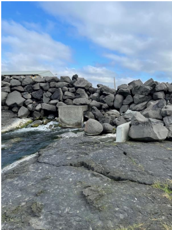
Mynd 2.6 Frárennsli á leið út í sjó. Ljósgrár veggur, hægra megin á mynd, var settur upp til að koma í veg fyrir að frárennsli renni yfir klappir.
